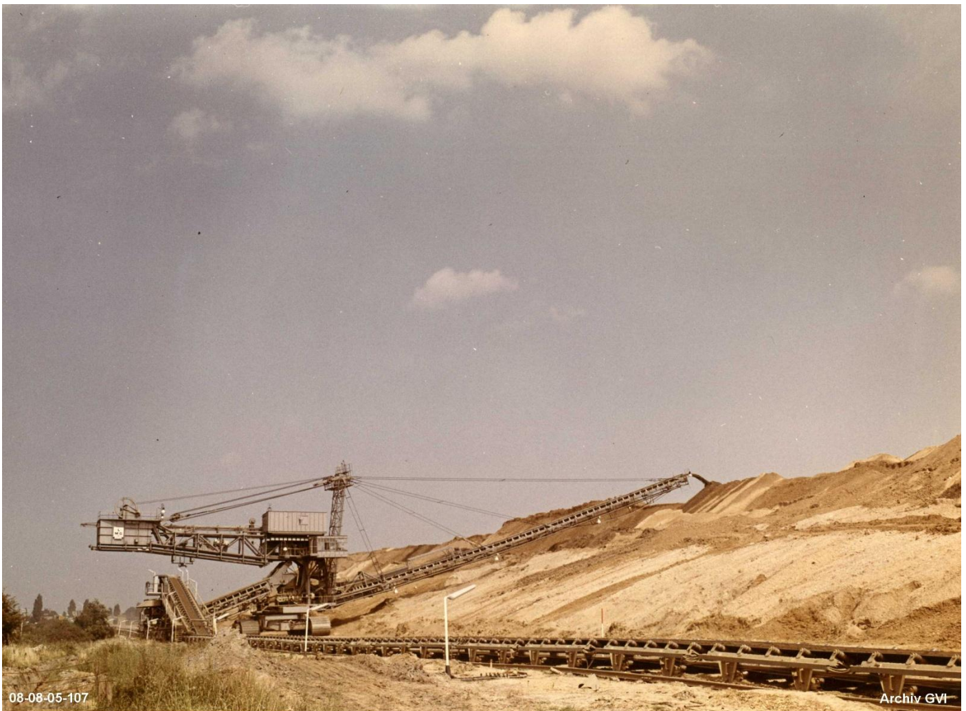
Goltsteinkippe im Bereich Meröden: Absetzer im Betrieb
