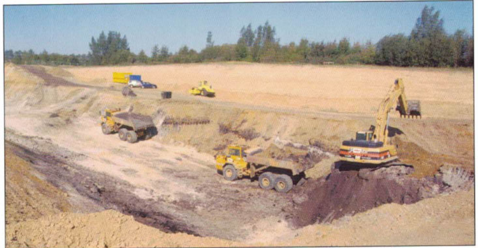
8 Erstellen eines Geländeeinschnittes im Sonderbetrieb
