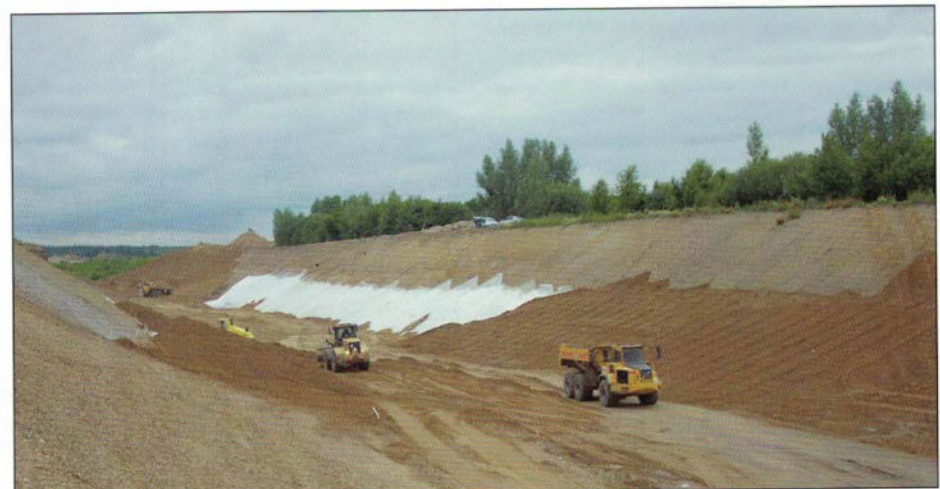
9 Geländeeinschnitt mit teilweise sichtbaren Geokunststoffen
